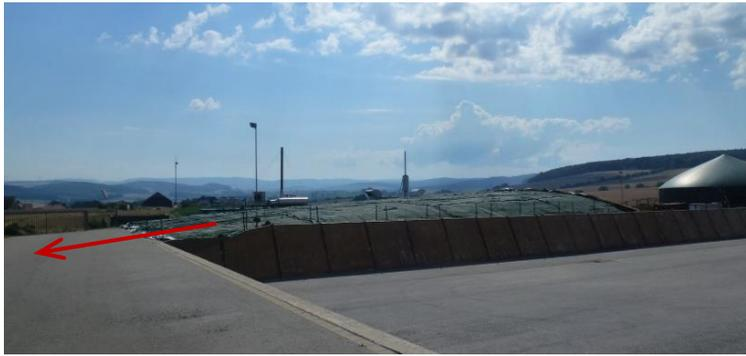
**Abbildung 3: Rückwärtige Entwässerung der Folie (Foto: Dederichs, Landkreis Northeim)**
