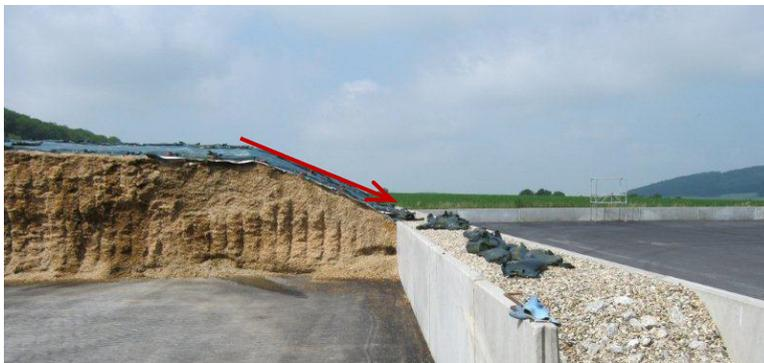
**Abbildung 4: Seitliche Entwässerung der Folie (Foto: Dederichs, Landkreis Northeim)**
